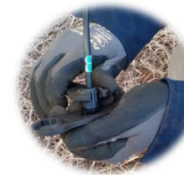
Atividades de substituição dos conectores MC4 do seriamento entre os módulos PV da string 3.3.12.1.5 de BOH-3 CI, em decorrência de sua carbonização, ocasionada por um possível curto-circuito ou sobre corrente.
