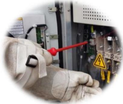
Atividades de substituição dos inversores de BOH-1, BOH-2 e BOH-3 em decorrência de falhas internas, onde se faz necessário o envio para manutenção externa.
