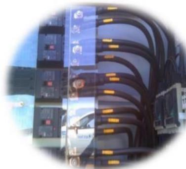
Atividade de termografia nos componentes elétricos internos dos transformadores de BOH 1, BOH 2 e BOH 3, como ação preventiva para evitarmos sobreaquecimentos desses componentes, podendo ocasionar deterioração e/ou curto-circuito. Obs.: caso identificado ponto quente, é realizado a manutenção corretiva (crimpagem, reaperto, substituição, limpeza etc.).
