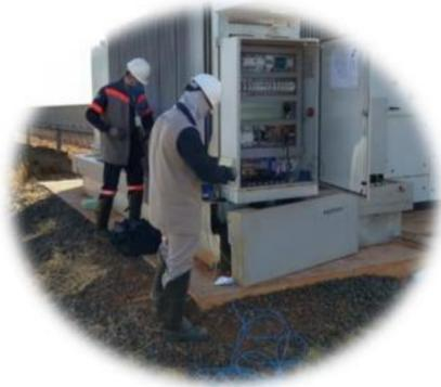
Atividades de substituição do cabo de comunicação (cabo de rede) entre o painel da WS-4.2 (Wether Station) o swith de comunicação localizado no painel do serviço auxiliar da TS-4.2, ambos de AGV IV, em decorrência de seu rompimento ocasionado possivelmente por animais roedores.
